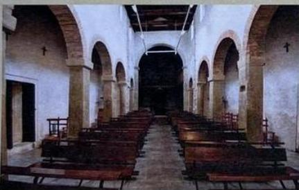
La iglesia de Gobiendes conserva las características tipológicas de la arquitectura asturiana: planta basilical con una nave central de 9,70 m de longitud y 4,20 m de anchura, separada de las naves laterales meridional y septentrional —de 1,40 m de anchura— por sendas arquerías con arcos de medio punto con dovelaje en ladrillo, y apoyando sobre capiteles imposta lisos, que en número de tres descansan en pilares monolíticos de sección cuadrada, con 40 cm de lado y basas con molduración.
